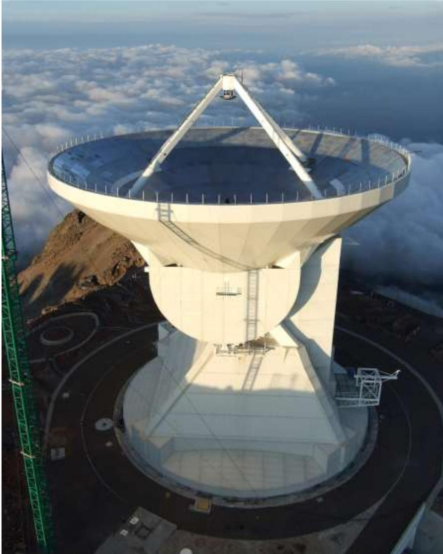
El Gran Telescopio Milimétrico Alfonso Serrano ubicado en el Volcán Sierra Negra, Puebla a 4600 metros de altura. Los 32-m de diámetro de una antena de 50-m están dentro de la estructura del tetrápodo. Las primeras observaciones científicas se seguirán realizando con un diámetro de 32-m.
